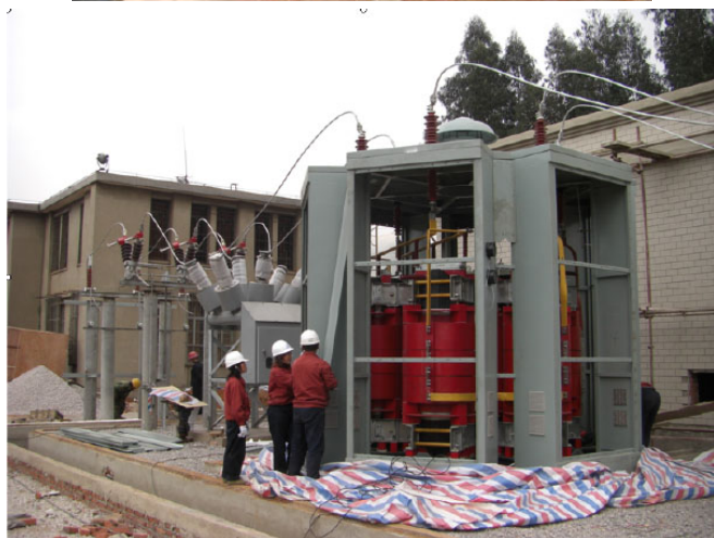
Рис. 4. ВТСП токоограничитель с насыщенным магнитопроводом InnoPower.
