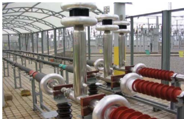
Рис. 2. Трехфазный ВТСП кабель InnoPower.
