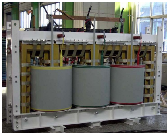
Рис. 3. Трехфазный ВТСП трансформатор ИЕЕ/Terbian Electric 10,5 кВ/400 В, 630 кВА.
