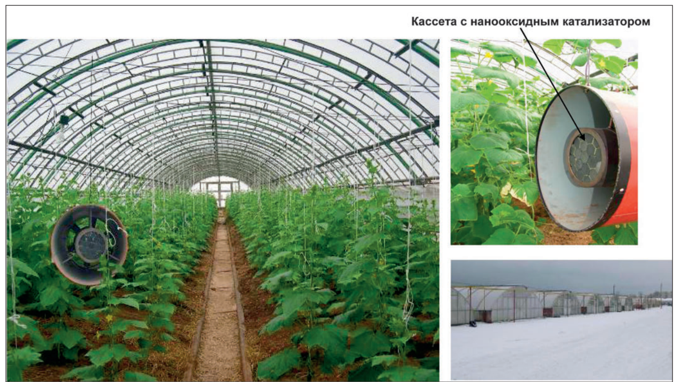
РИСУНОК 2 | Каталитические воздухонагреватели (КВН) седьмой сезон в эксплуатации в десяти теплицах. Экономия энергии 50–60 % (ЗАО «ПРИБОСКОЕ», Новосибирская обл.)
