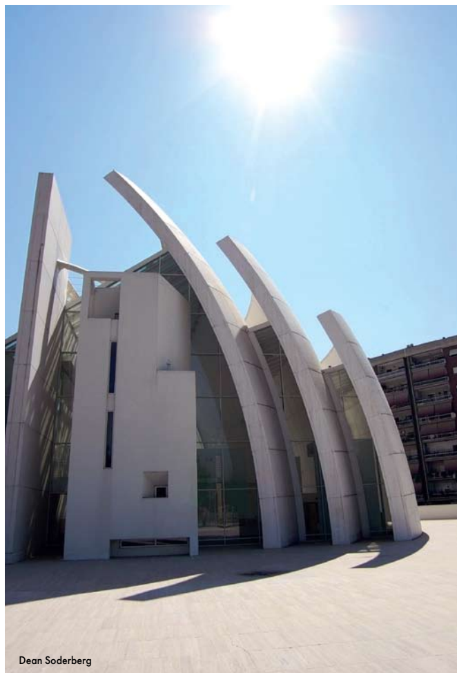
Ослепительную белизну церкви Dives in Misericordia в Риме обеспечивают наночастицы диоксида титана
