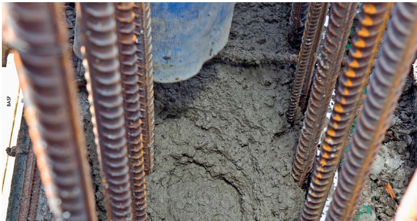
Самокомпатирующемуся бетону не нужна вибрация, он густеет благодаря наночастицам поликарбоната
