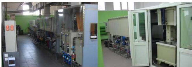
Рис. 1. Линия подготовки поверхности и линия хромирования.
