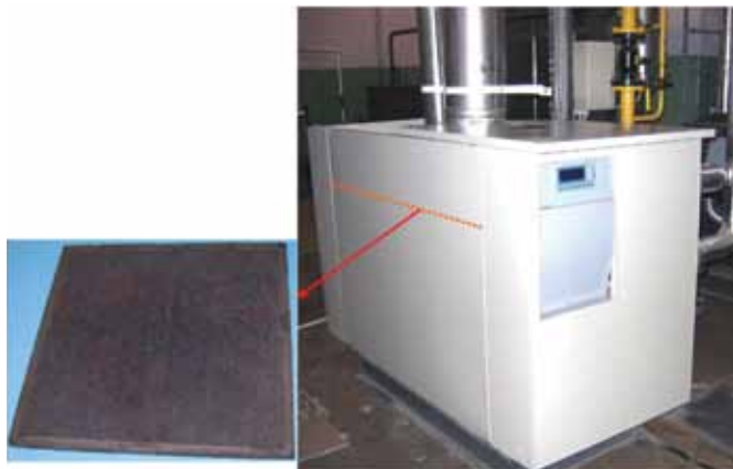
Рисунок 1. Каталитический элемент из высокопористого ячеистого сплава хромаль для экологически безопасных теплогенераторов типа КТГ-0.5
