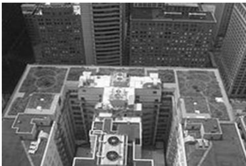
Рис. 3. «Зеленая крыша» здания муниципалитета в Чикаго, Иллинойс
