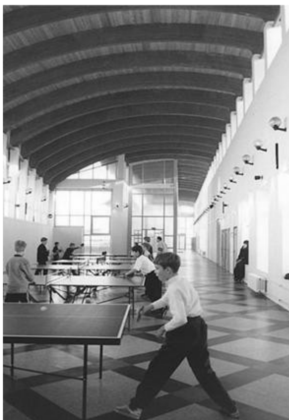
Иллюстрация 1. Перекрытия школьного физкультурно-оздоровительного блока, выполненные из КДК
